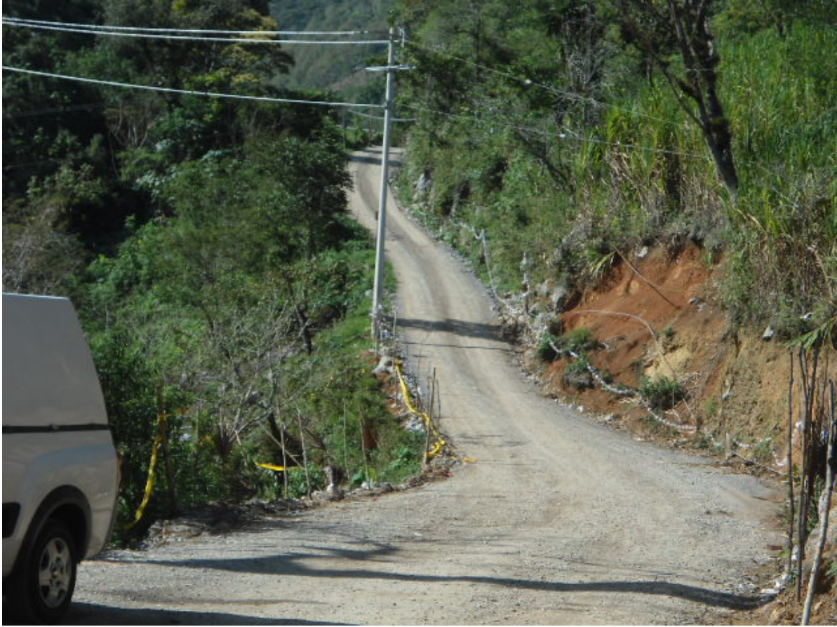
REVESTIMIENTO CAMINO- ZAPOTLA
