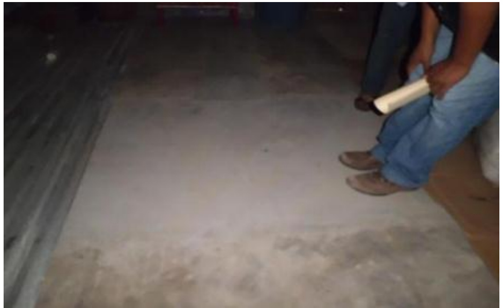
Rehabilitación de piso.
